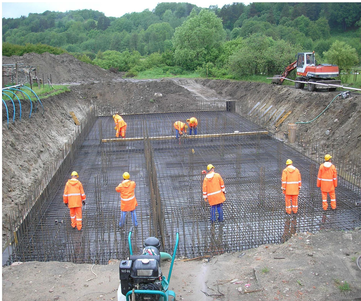
Stacja Uzdatniania Wody w Pręgowie Zbrojenie płyty dennej budynku głównego Stacji Uzdatniania Wody
