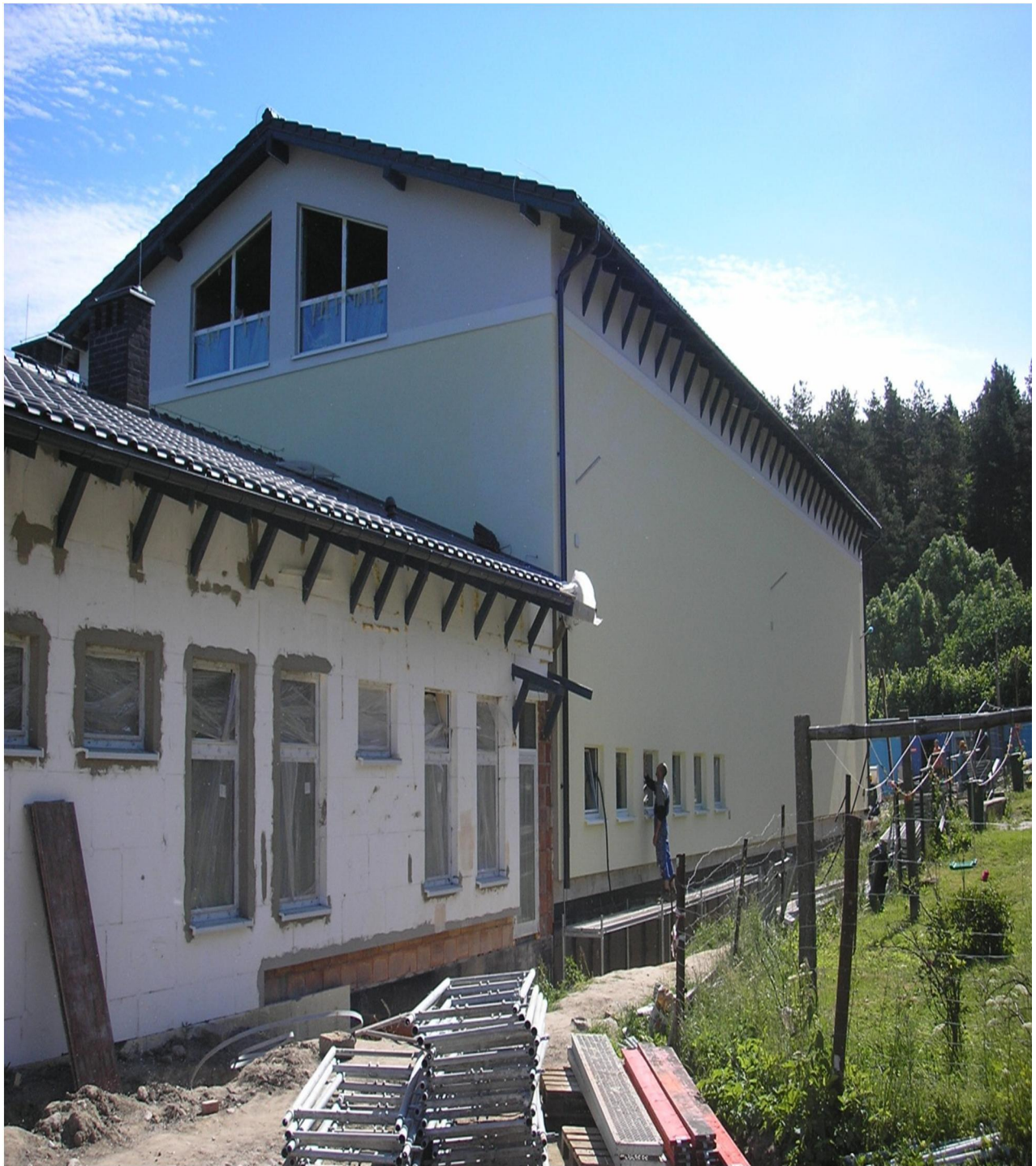
Widok na budynek Stacji Uzdatniania Wody w Pręgowie od strony pld.-zach. podczas prac elewacyjnych
